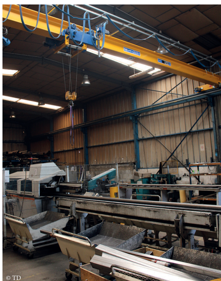
L'outil de pliage et de découpe à l'entrée de l'usine est surmonté d'un pont levant afin de travailler les pièces brutes visibles dans les racks en arrière-plan.
